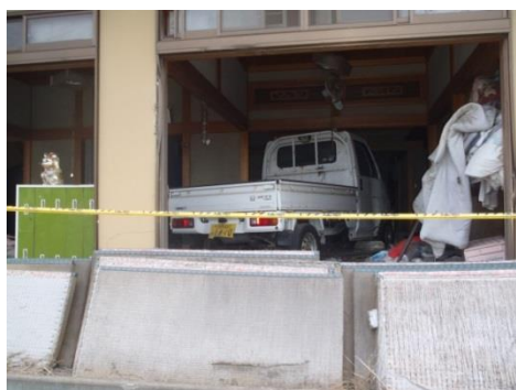
津波で家の中に飛び込んだ車
