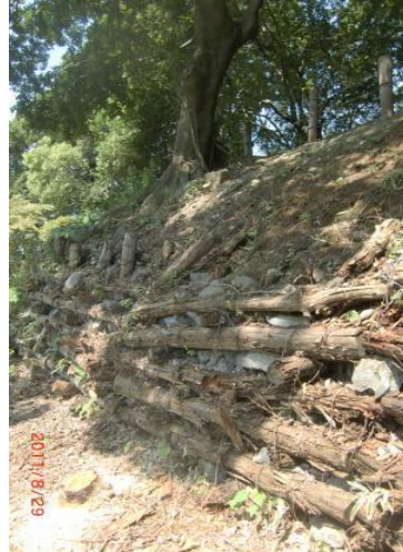
杭の腐敗と、根の張り出しもあるのだろうか、足元が崩れています。今年度予算で、早速にも補修工事をしてほしい。
