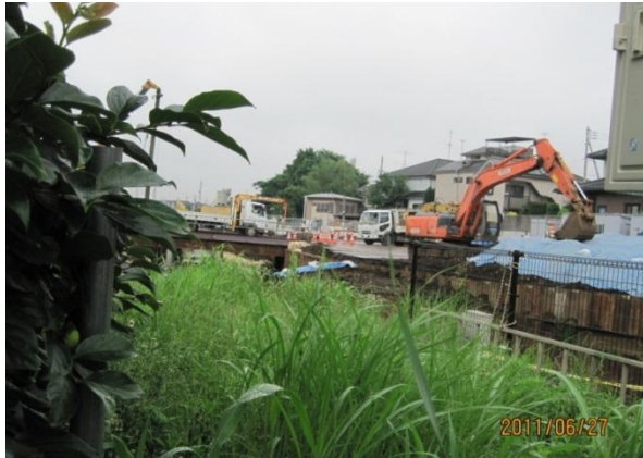
(写真2) 高木橋工事現場付近
