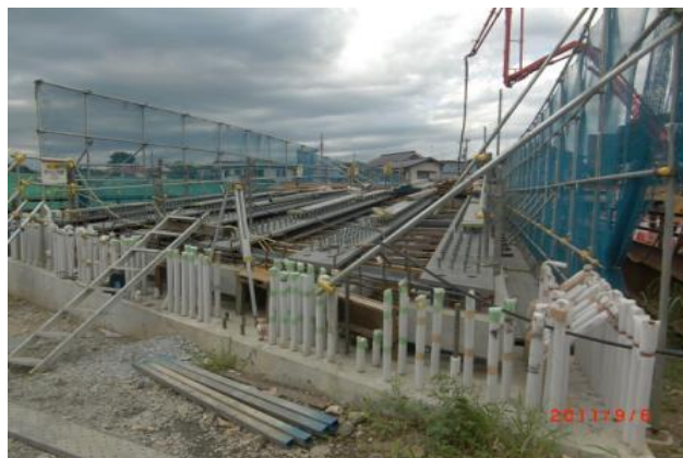
完成が待たれる 境橋工事
