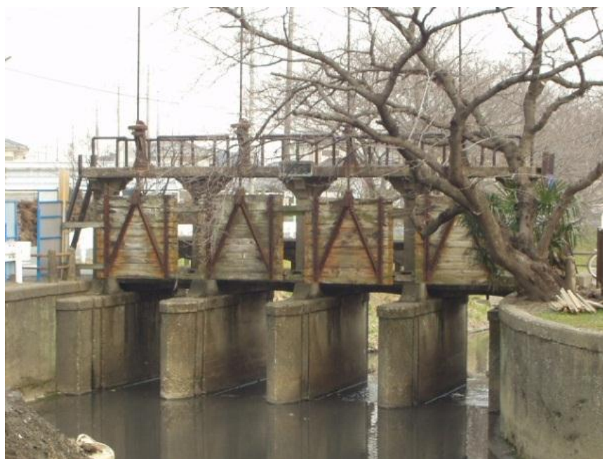
新河岸川に設置されている田谷水門(川越市)
