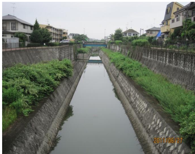
(写真3) 河道内調節池
