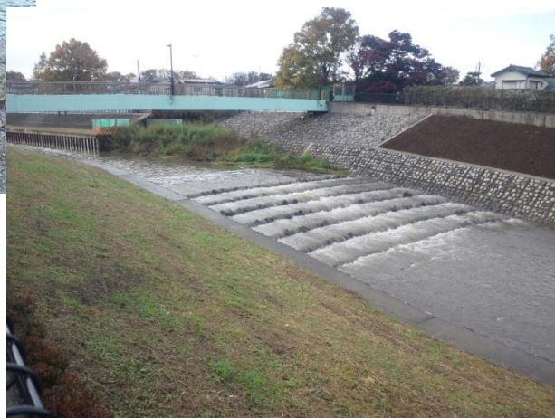
全容が見えるようになった自然石を使った8段の落差工
