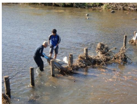
ゴミの撤去作業
