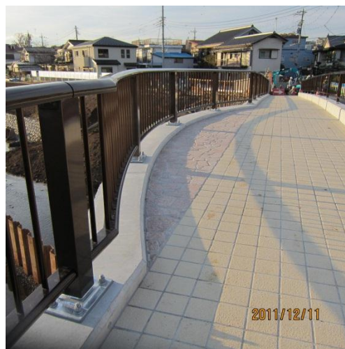
境橋の完成(歩道清瀬側から)
