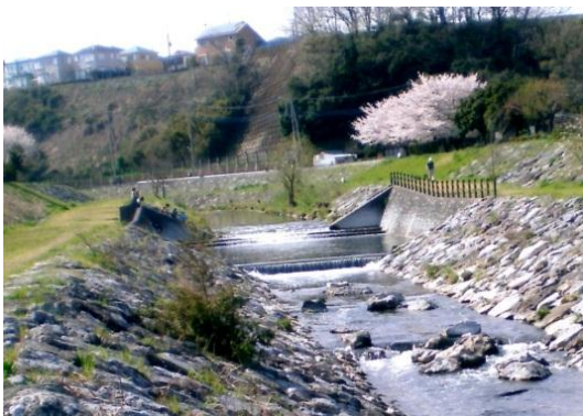
改修進む中里4丁目付近（後方の崖が「赤バツケ」）
