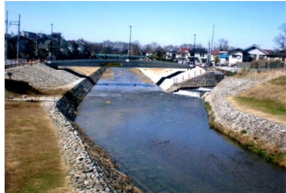
(清瀬橋から空堀川との現合流点を望む)
