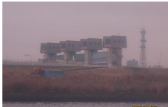
現岩淵水門 洪水時、荒川の水が隅田川へ流入を防ぐ。
