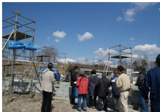
水理模型実験現場（つくば市）
