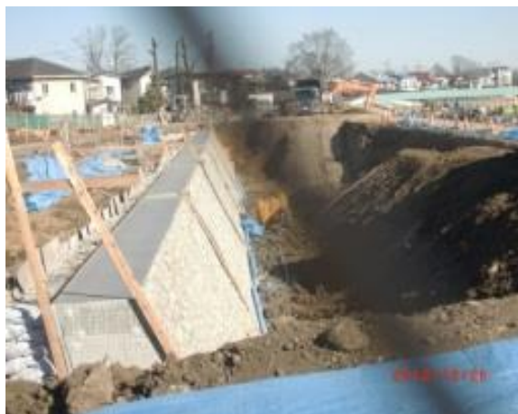
(新合流河川左岸工事)
