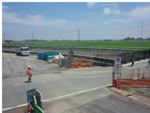
改修工事が進む武蔵水路
