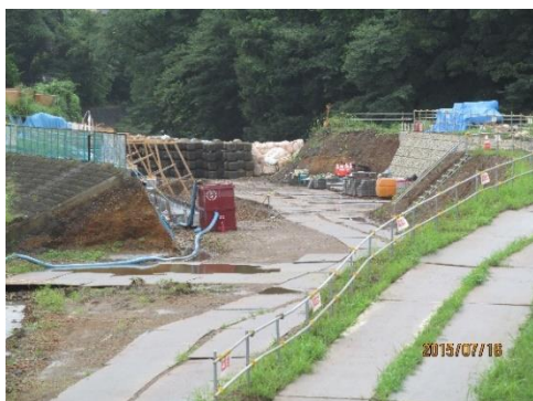
新柳瀬川護岸工事
